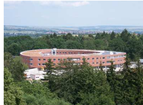
Außenansicht MRV Mühlhausen
